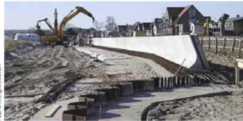
Bau des Küstenschutzes: Die Spundwand ist eingesetzt, der Betonholm ist z. T. bereits aufgesetzt worden.
