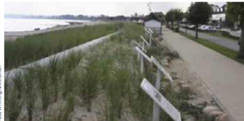
Nach Fertigstellung ist von der Küstenschutzmaßnahme nur die Spitze des Betonholms sichtbar.
