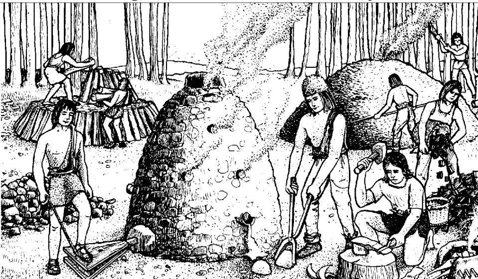
Eisengewinnung und Werkzeugherstellung in der Eisenzeit
